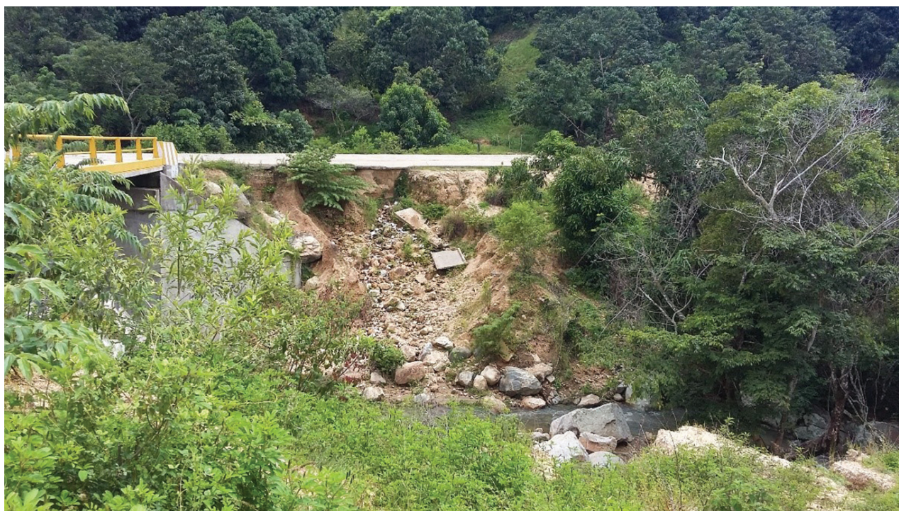
Derrumbe del muro de contención de un puente en la comunidad de Platanillo, Coyuca de Benítez; un ejemplo de obra pública de mala calidad. Foto: Unicam-Sur
